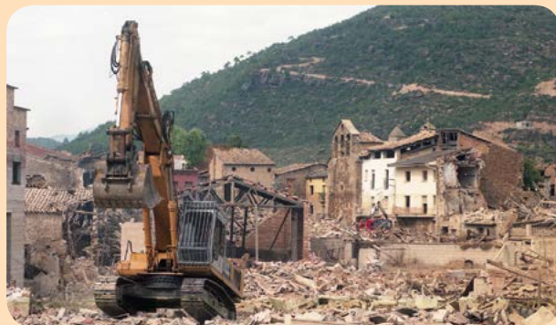
A finals de 1982, el Consell de Ministres va declarar l'inici urgent de les obres del pantà de Rialb i aprovà les primeres expropiacions forçoses. Demolició del poble de Tiurana. Any 1999. Procedència: diari Segre. Autor: Elena Vallés.
