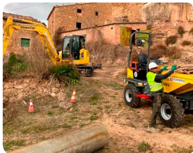
Treballs de demolició d'edificis al nucli de la Clua (Foto: CHE).
