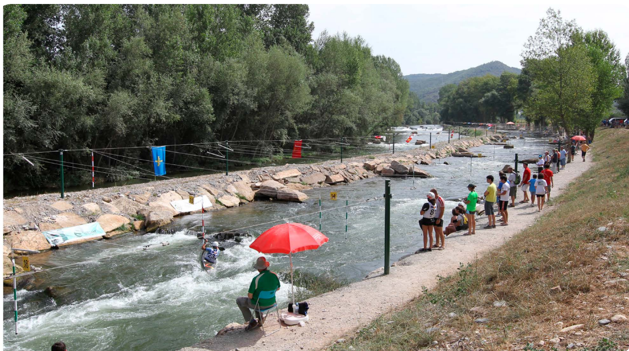
Adecuació i millora del Canal d'Aigües Braves de Ponts
